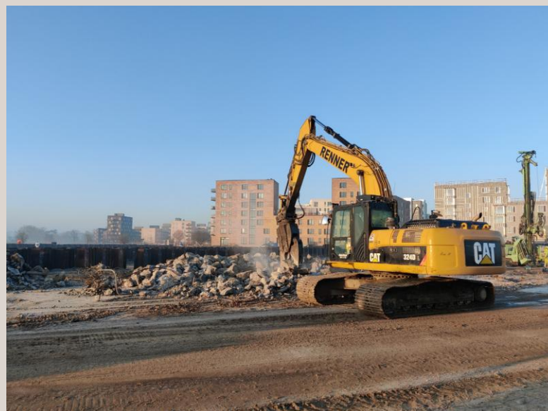
Nedknusning af beton og supp. forklassificering
