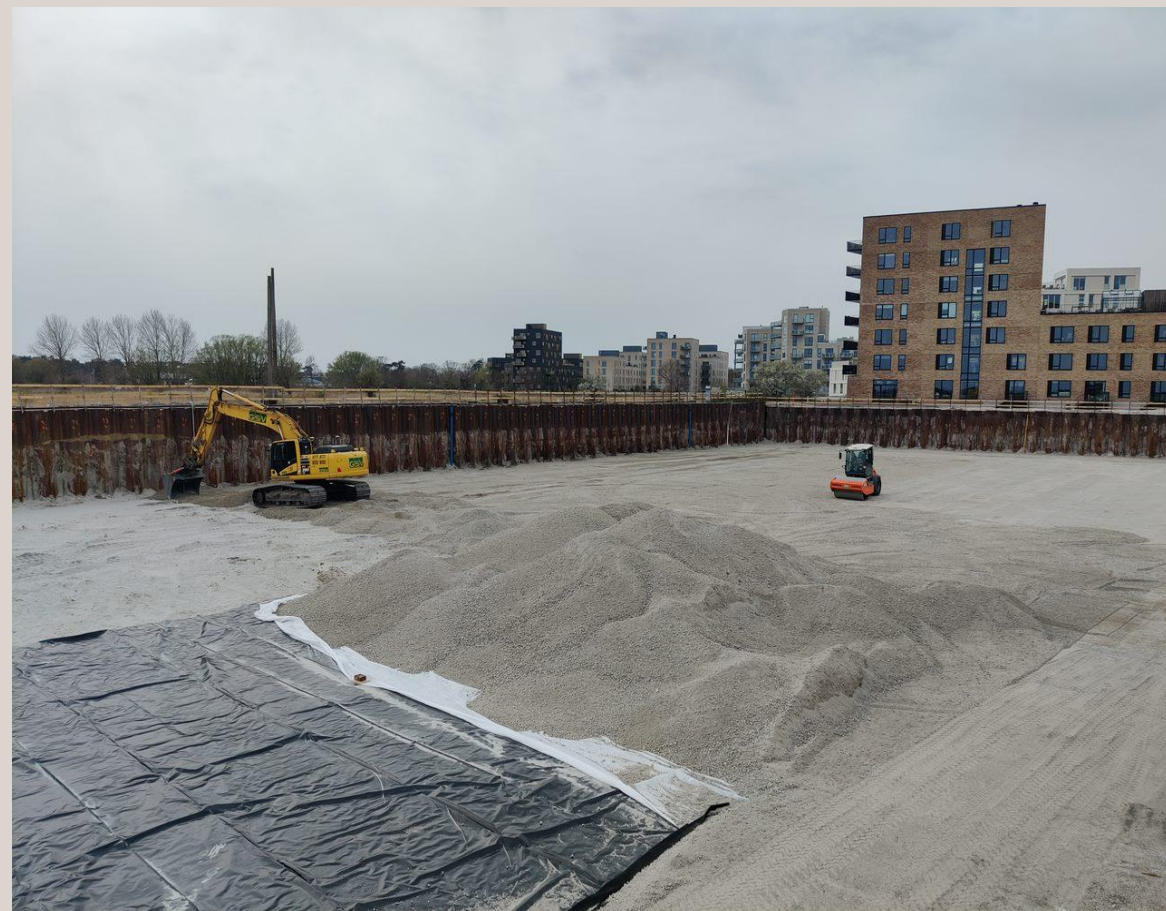
Udlægning af membran og afretning af beton.
