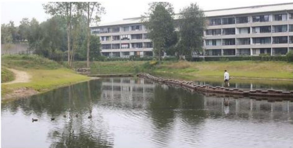
Eksempel på regnvandsbassin med permanent vådt renselumen
