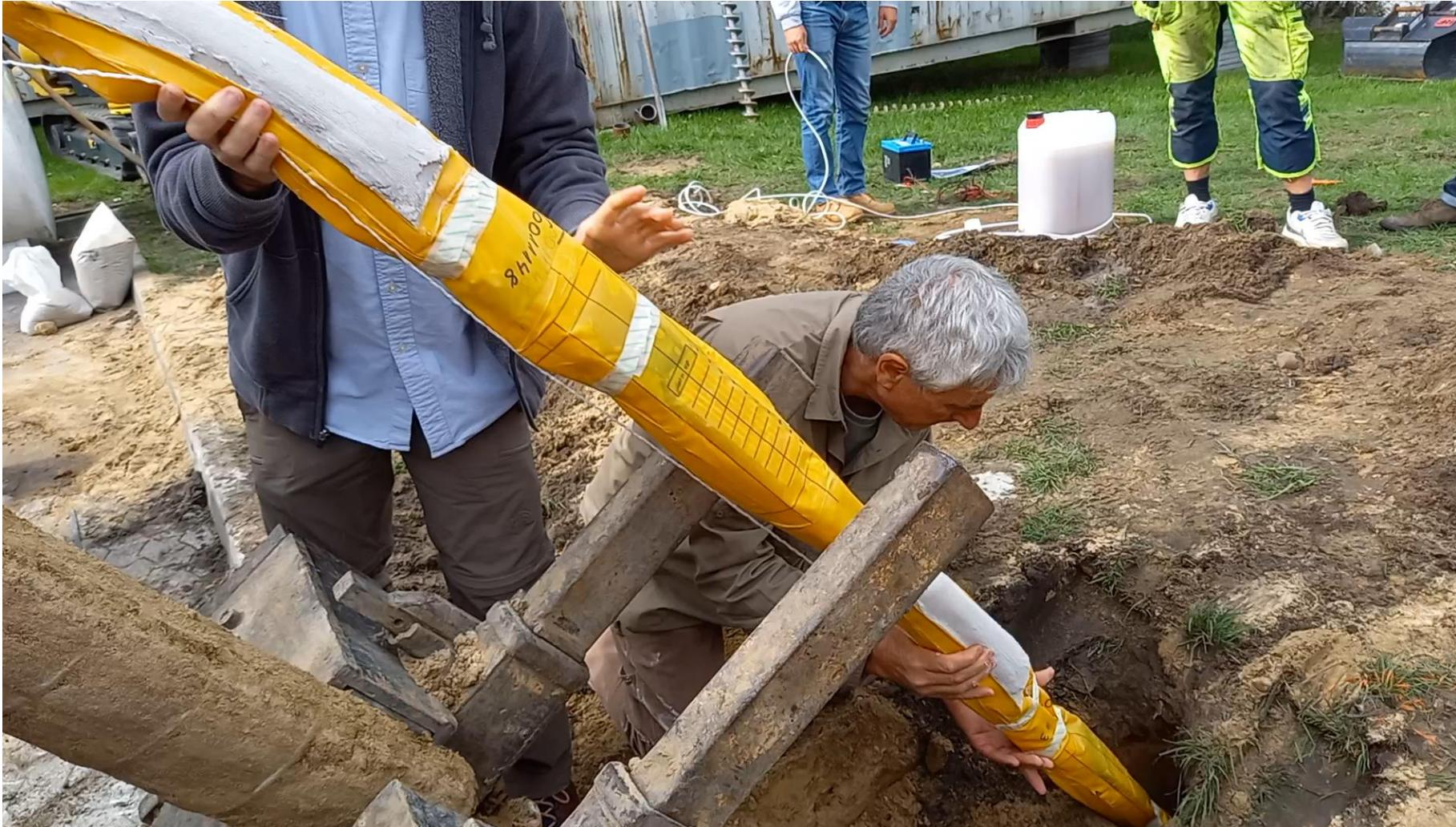
"anakondaen" pumpes op (fyldes med cement) så den forsegler kontakten til indersiden af borehullet dernæst forbindes alle slanger og ledninger til prøvetagningspanelet
