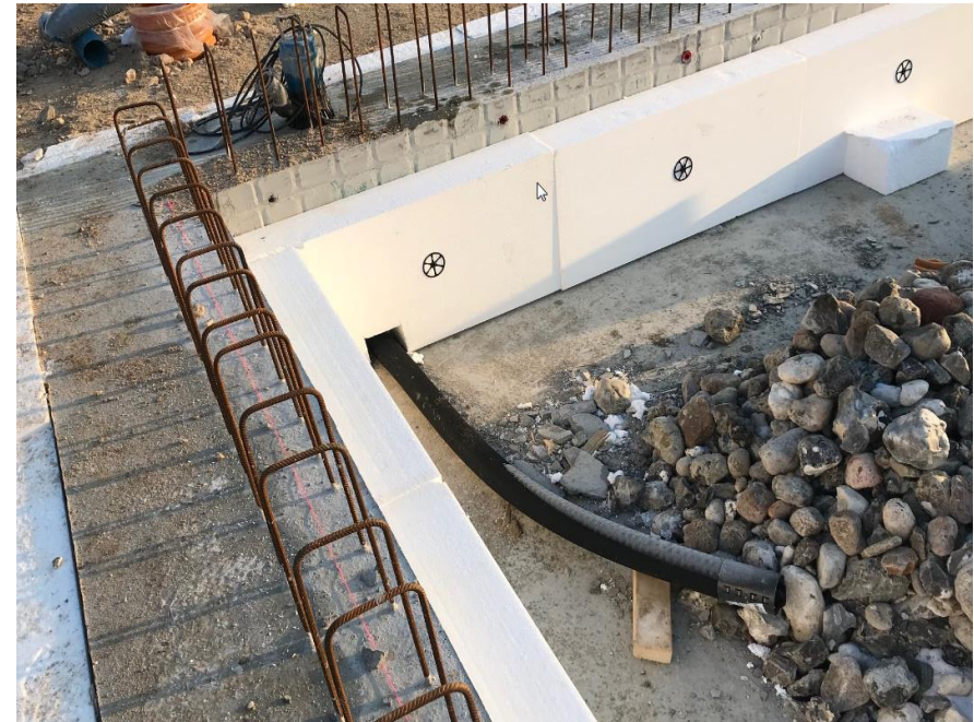
Drænslange ført ud gennem fundament
