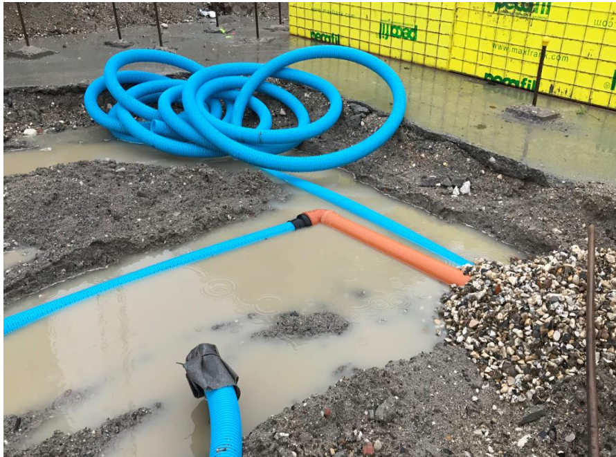
Ventilationsdræn indvendigt i bygning
