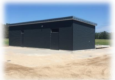
Afværgeanlæg og boringer (bygning, servicering, renovering, demontage)
